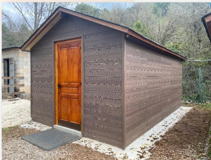
Cabaña nº10 con el nuevo revestimiento
